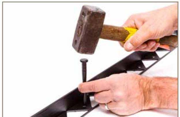
Wenn Sie die Randleisten in die endgültige Position gebracht haben, befestigen Sie sie mithilfe der Fixierstifte im Boden. Bei besonders weichem Untergrund benutzen Sie bitte längere oder andere Fixiermittel. Diese Angaben sind lediglich Hinweise und müssen an die Gegebenheiten vor Ort angepasst werden.
